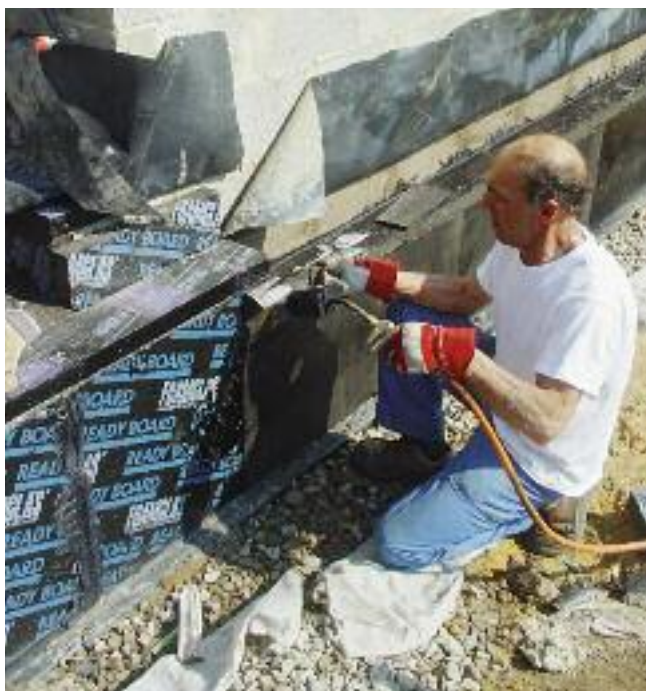
Soudage de la membrane d'étanchéité sur le FOAMGLAS® READY BOARD.
